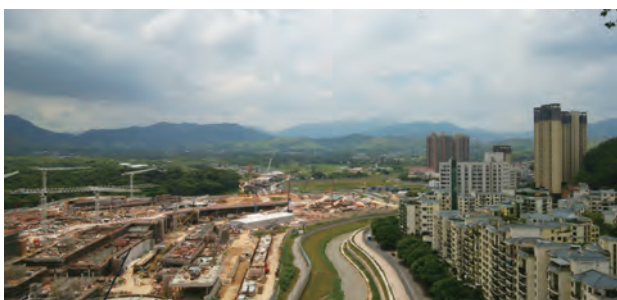
2017年8月、建設中の蓮塘口岸（国境検問所） 中央の川より左は香港、右は広東省深圳市
