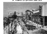
大阪港拠点整備
