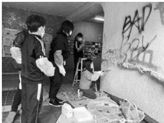
写真26 下地材を塗る様子
